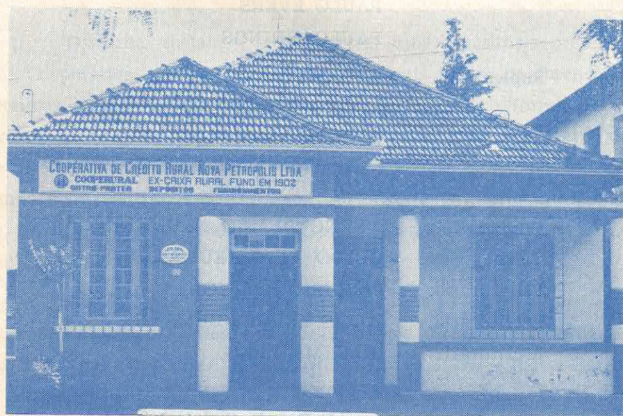
Vista da atual Sede Social própria da nossa Cooperativa de Crédito, na cidade de Nova Petrópolis, bem em frente à Praça da República.
